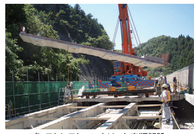
プレストレストコンクリート床版架設
