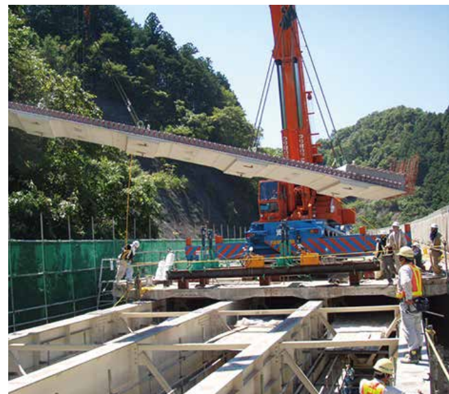
プレストレストコンクリート床版架設
