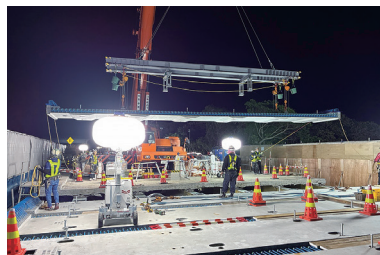
新設床版の設置状況
