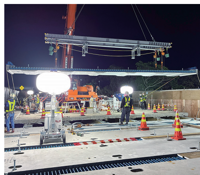
新設床版の設置状況
